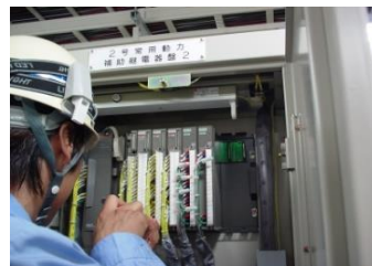
I/O試験・変換器調整
