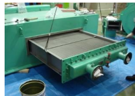
発電機冷却器 引抜リーク試験
