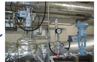
調節弁 ループ試験(実動作)
