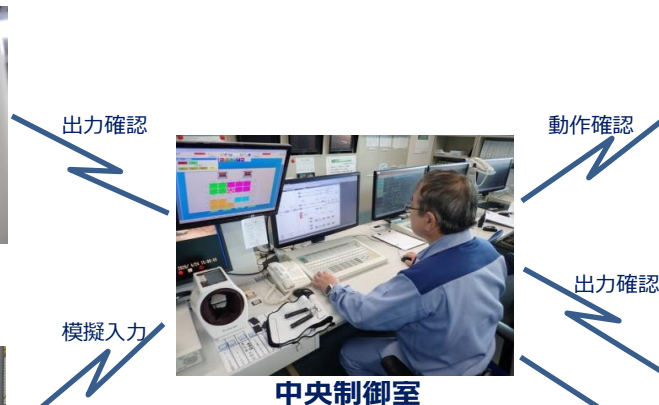
I/O試験・変換器調整
